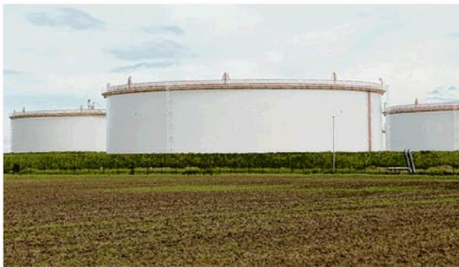
Sie markieren das Ende der Transalpinen Pipeline: riesige Erdöltanks vor den Toren von Ingolstadt.
